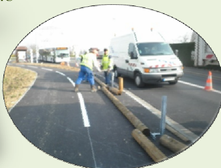
Mise en place de poteaux de sécurité
